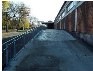
Rampe am Eingang
